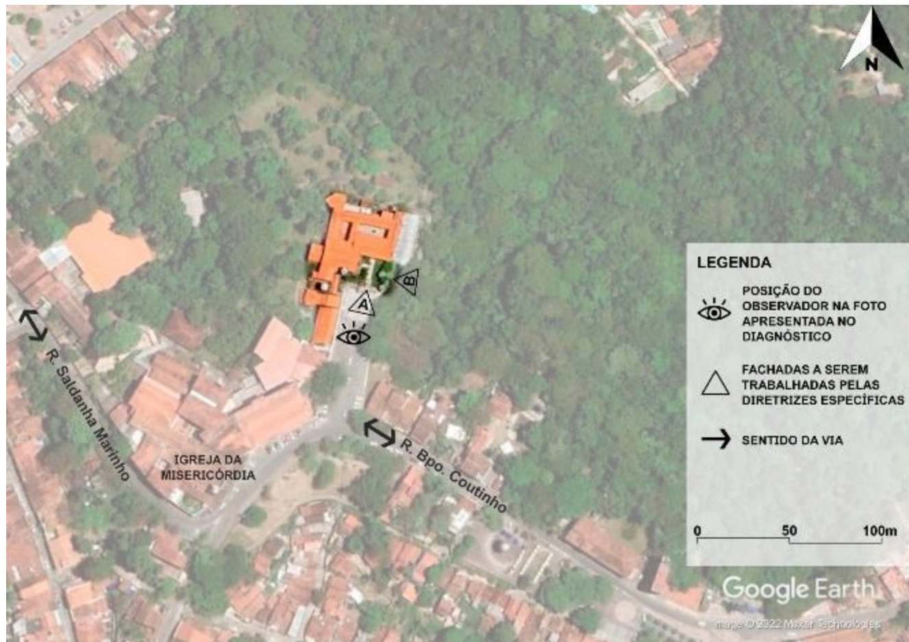
Figura 29 – Contexto urbano da Igreja e Convento de Nossa Senhora da Conceição
