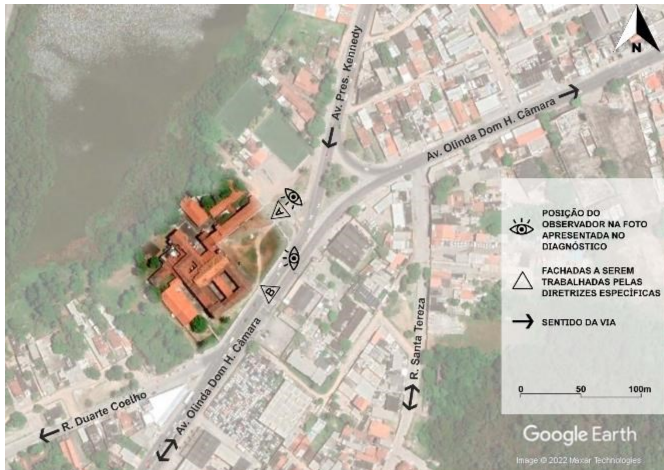
Figura 9 – Contexto urbano do Convento de Santa Tereza e Igreja de Nossa Senhora do Desterro
